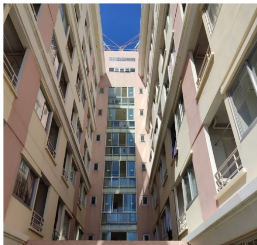
ภาพที่ 4-2 ช่องเปิดระบายอากาศภายในอาคาร
