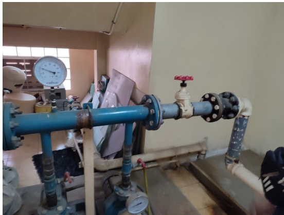
ภาพที่ 4-7 ระบบส่งน้ำประปาไม่พบรอยรั่วซึม
