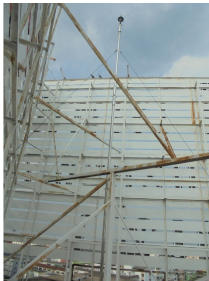
ภาพที่ 4-23 เสาหล่อฟ้าและต่อระบบลงดิน
