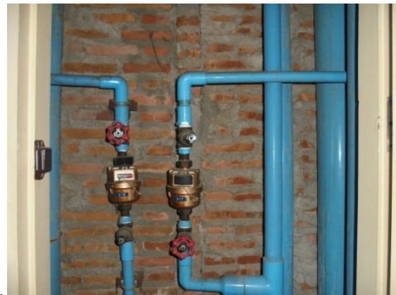
ภาพที่ 4-7 ระบบส่งน้ำประปาไม่พบรอยรั่วซึม
